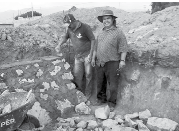
2018年11月，鋪設地基
